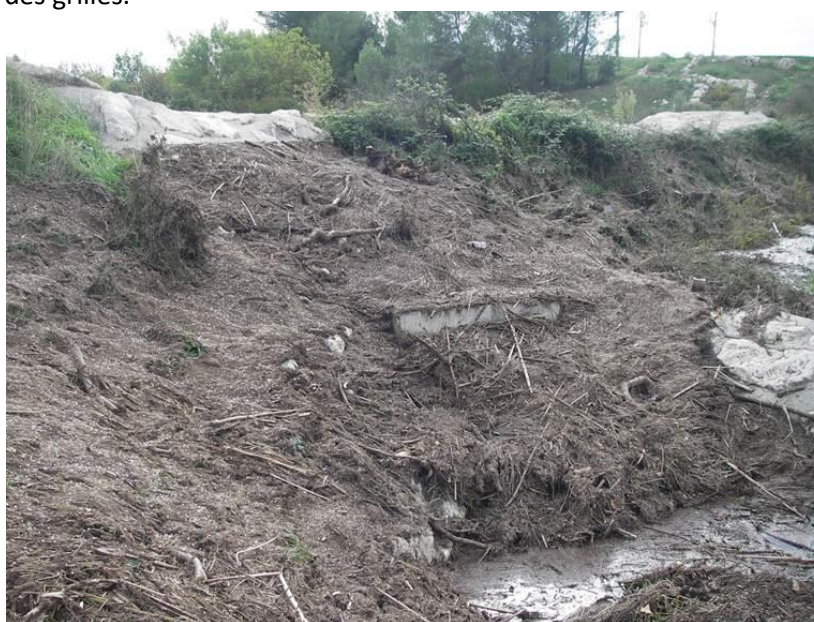
Figure 10 : Embâcles sur la grille en amont du barrage lors de la crue de 2014
