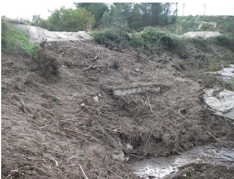
Figure 23 : Laisse de crue sur le déversoir après l'évènement du 29 septembre.
