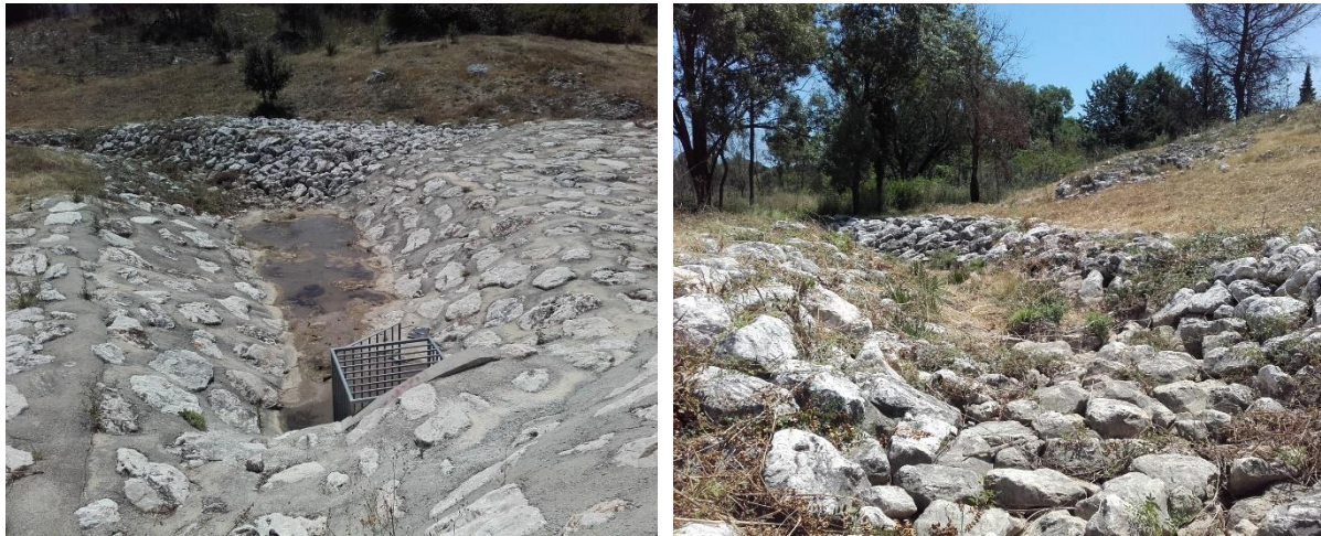
Figure 15 : A gauche, débouché de la buse de fuite actuelle et enrochements liaisonnés / A droite : enrochements libres dans le lit du cours d'eau en aval
